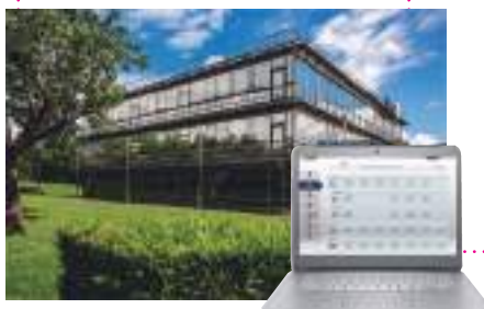
Sistema de gestão de edifícios (BMS)
